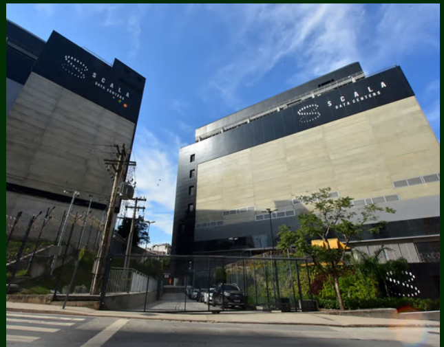
Data Center da BMF – Tamboré
